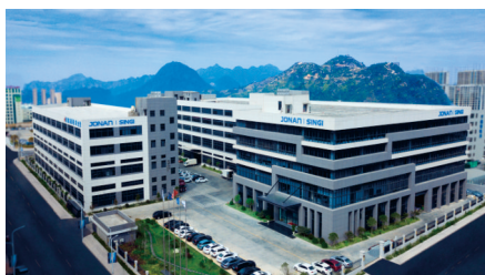
浙江信基电气股份有限公司工业园 Zhejiang Singi Electrical LLC
